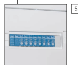
DISTRIBUTORE A PAVIMENTO PIANO TERRA
