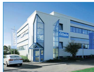
Zentrallager und Elektromechanik-Fertigung Loßburg
