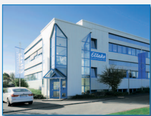
Zentrallager und Elektromechanik – Fertigung Loßburg
