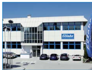
Centro de distribución y administración en Fellbach
